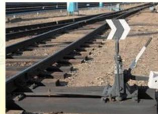
**Стрелка—часть стрелочного перевода, состоящая из рамных рельсов, остряков и переводного механизма.**
