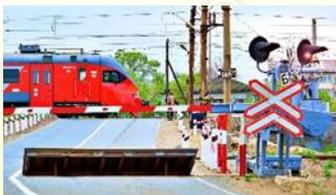
**Переезд- место пересечения железной дороги с автомобильной дорогой.**
